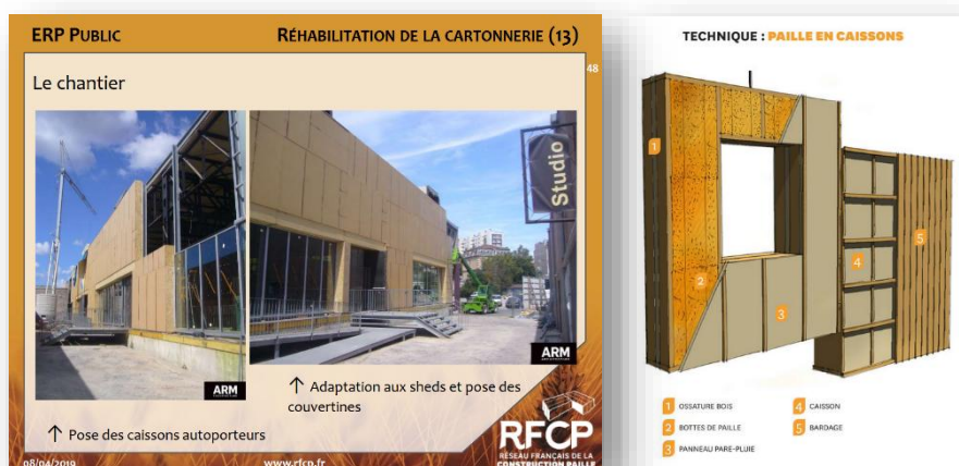
Exemple de projet caissons sur ossature existante dans les Bouches du Rhône et schéma des caissons paille du RFCP
